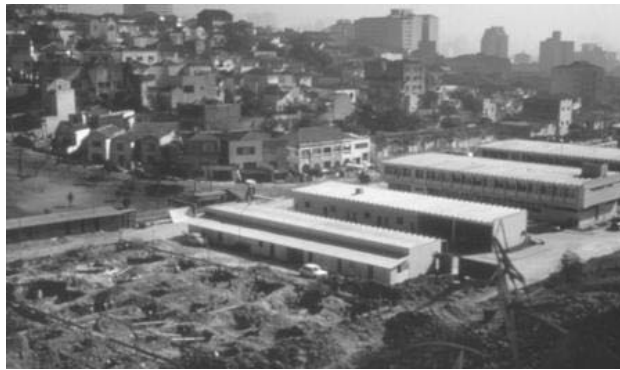
Figura 16 - Detalhe das fundações que deram origem ao pavilhão principal do 3º CTA Fonte: sítio do 3º CTA < www.3cta.eb.mil.br >
