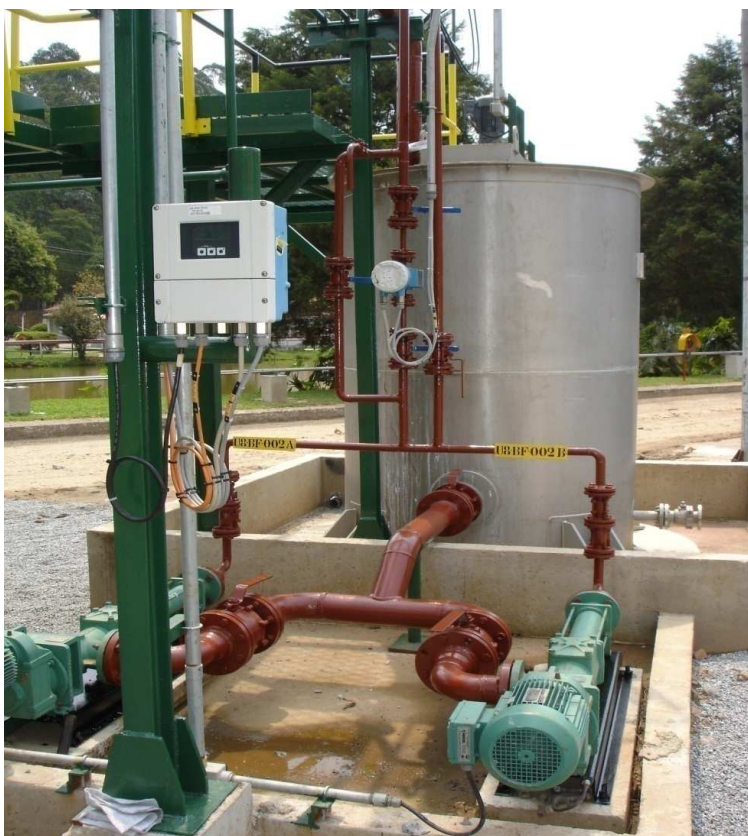
Foto 11. Tanque de Acúmulo de Lodo. (INDÚSTRIA PETROQUÍMICA, 2008)
