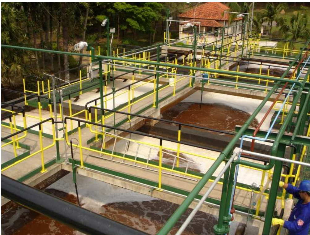
Foto 5. Tanque de Aeração - U8-RE-001/002/003. (INDÚSTRIA PETROQUÍMICA, 2008)
