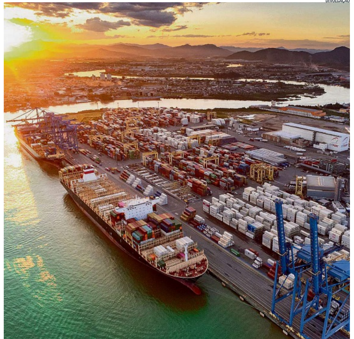
Portonave vai aprofundar o canal de navegação para 17 metros para receber navios com até 400 metros de comprimento
